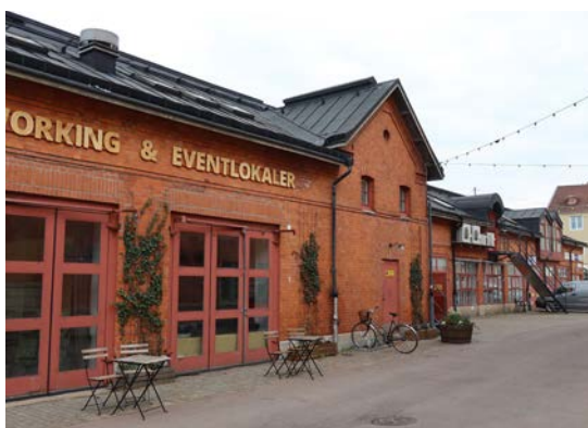
Mittpartiet sett från gårdssidan. Muröppningar för äldre körportar har ersatts med sentida, glasade dörr- och fönsterpartier.
