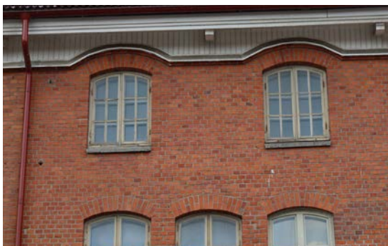
Till vänster snickarglädje i takfoten, till höger småspröjsade fönster, möjligen i original. Notera urtaget i takfoten för fönstervelvet.
