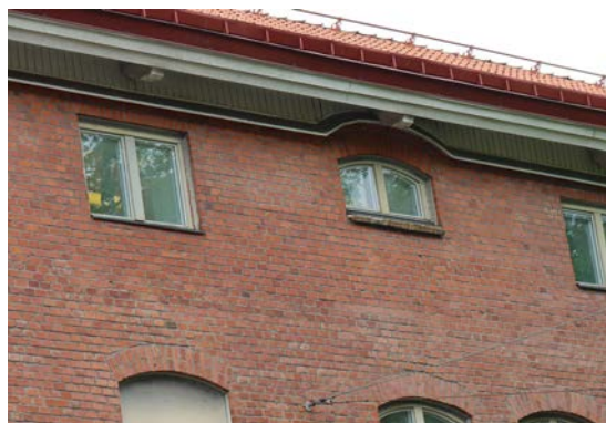
Ovan en lägre byggnadsvolym i 2 våningar mot Svangatan, och detalj på takfoten.
