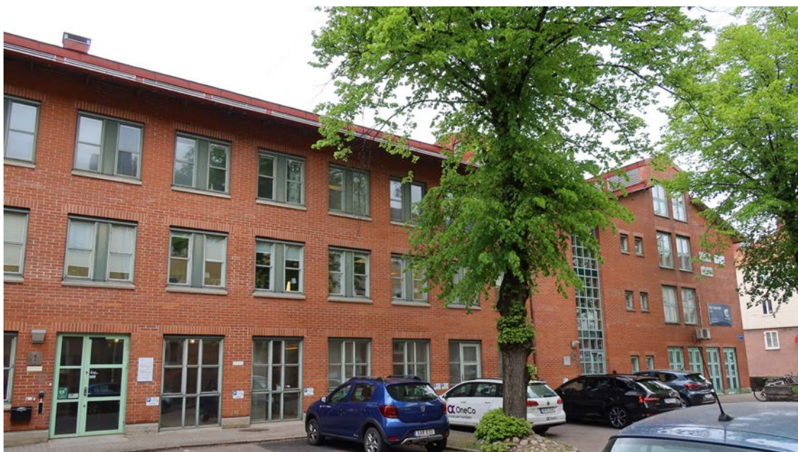
Fasad mot Svangatan.
